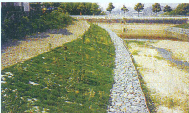
池の堆積土改良工—法面改修利用
