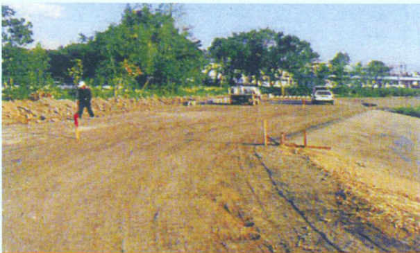
池の堆積土改良工—管理道路利用 (qc=1200KN/m以上)
