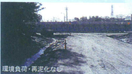
工事車両用仮設道路利用
