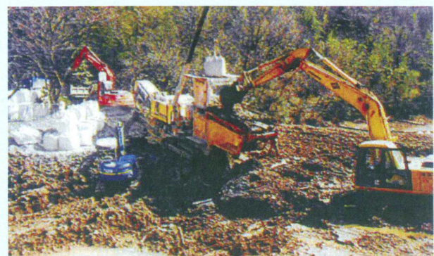
池の堆積土改良工—改良土搬出造成利用
